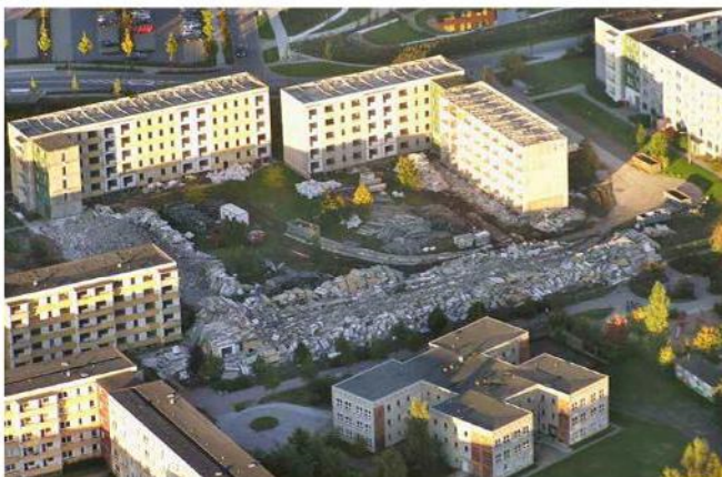
Rückbau von Plattenbauten am Friedenshof
