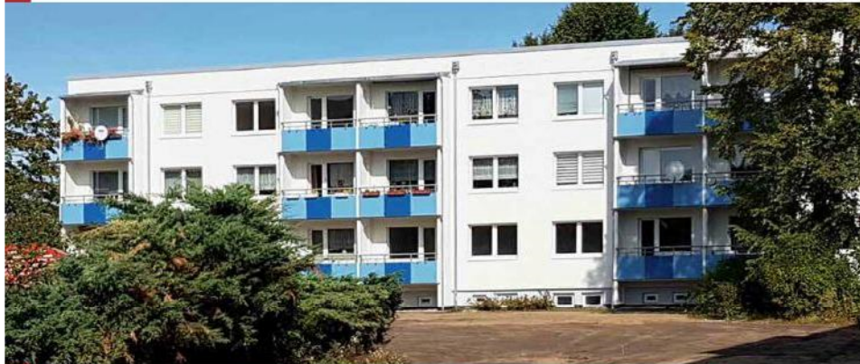
Abstockungsmaßnahme in den oberen Etagen der Prof.-Frege-Straße
