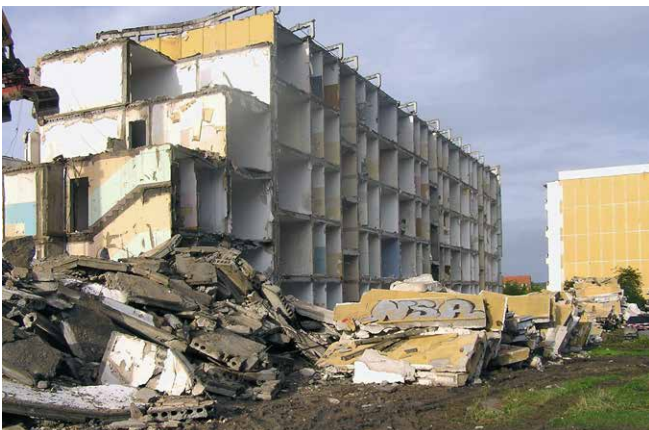
Rückbau von Plattenbauten am Friedenshof
