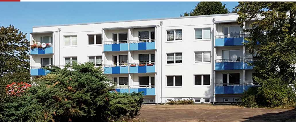
Abstockungsmaßnahme der oberen Etagen der Prof.-Frege-Straße
