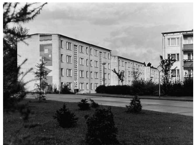
Wohngebiet Köppernitztal, erbaut 1971 bis 1972
