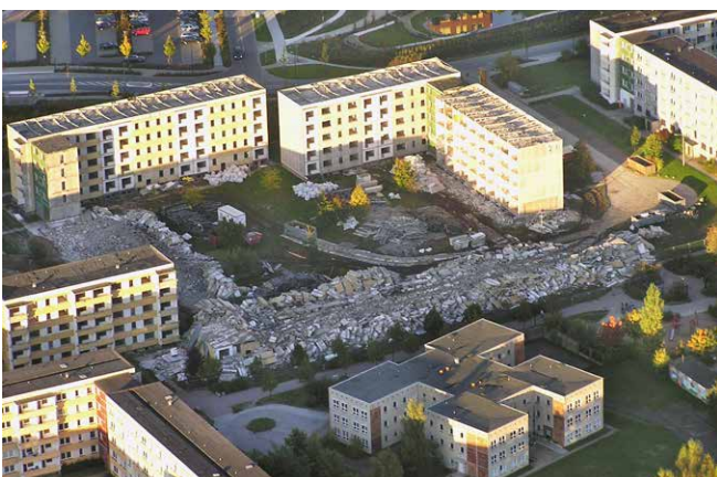
Rückbau von Plattenbauten am Friedenshof
