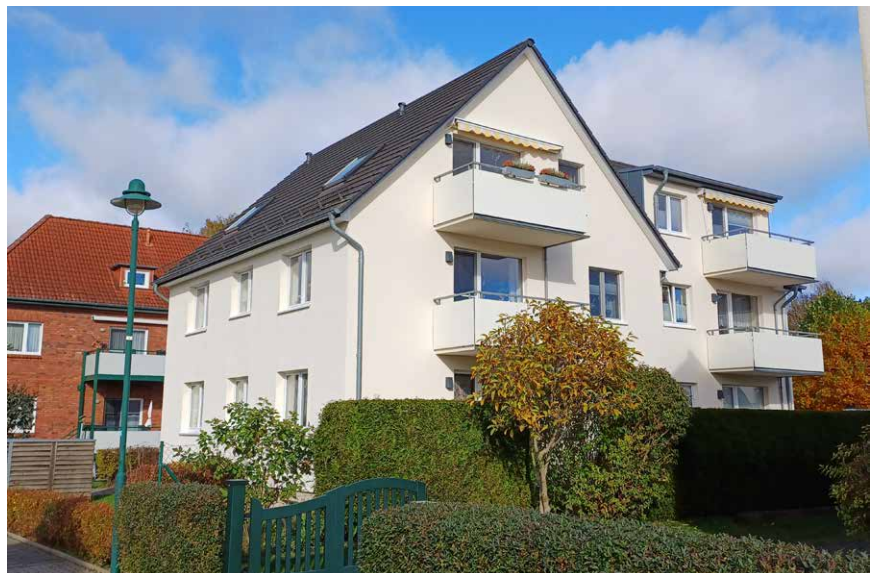
Pappelweg 2a nach der Sanierung
